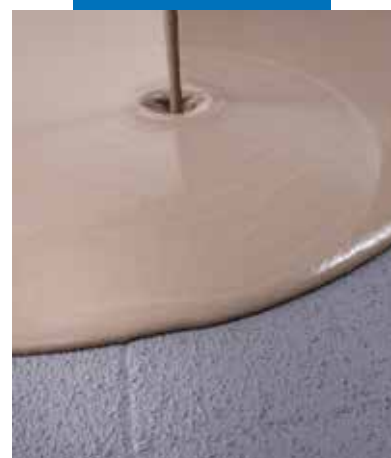
Εφαρμογή αυτοεπιπεδούμενου εξομαλυντικού κονιάματος Ultraplan σε στεγνό Eco Prim Grip πάνω σε υφιστάμενο δάπεδο
