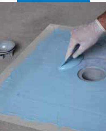
Εμποτισμός υφάσματος της σειράς Drain Vertical με Mapelast ® AquaDefense
