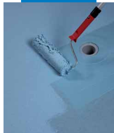
Εφαρμογή της δεύτερης στρώσης του Mapelastix® AquaDefense με ρολό
