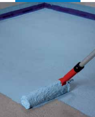
Εφαρμογή της πρώτης στρώσης του Mapelast ® AquaDefense σε τσιμεντοκονία δαπέδου
