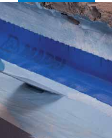
Τοποθέτηση Mapeband σε αρμό μεταξύ δαπέδου-τοιχίου με Mapelast ® AquaDefense
