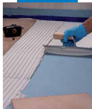
Τοποθέτηση πλακιδίων στην επιφάνεια του Mapelastix® AquaDefense
