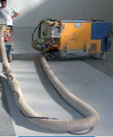
Προετοιμασία υποστρώματος με σφαιριδιοβολή
