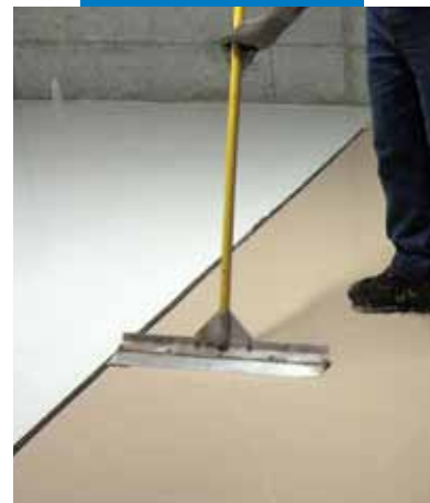
Εξομάλυνση του Ultrator αμέσως μετά τη διάστρωση
