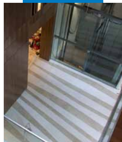
Ξενοδοχείο Design - Βουδαπέστη - Ουγγαρία . Δάπεδο Ultratop με όψη "μωσαϊκό αλά Βενετσιάνα"
