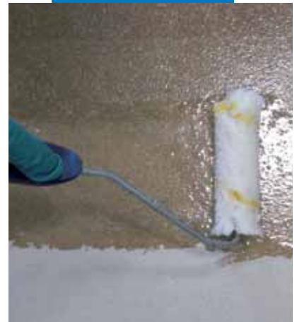
Όψη δαπέδου “μωσαϊκό αλά Βενετσιάνα”. Εφαρμογή του Mapefloor I 910
