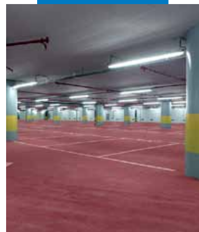
Κατασκευή δαπέδου με Ultratop κόκκινου χρώματος στο Κτίριο Berlaymont, Βρυξέλλες
