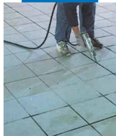
Σφράγιση αρμού διαστολής κεραμικών με Mapesil AC
