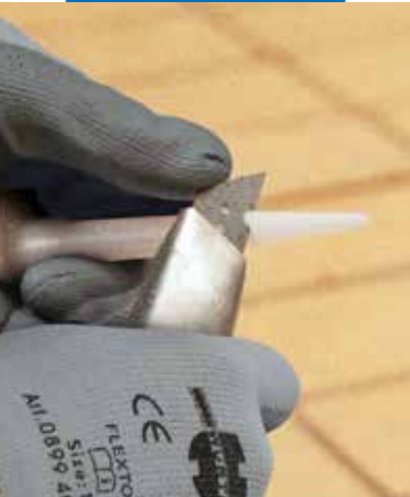
Κόψιμο του στομίου ώστε το άνοιγμα να ανταποκρίνεται στο μέγεθος του αρμού
