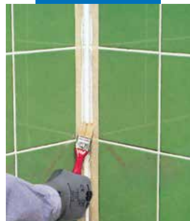
Εξομάλυνση του αρμού με σαπουνόνερο και ένα μικρό πινέλο
