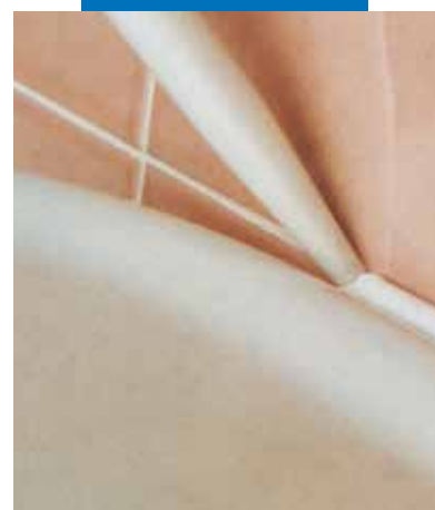
Σφράγιση ειδών υγιεινής
