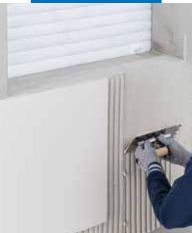
Εφαρμογή κεραμικών πλακιδίων μεγάλων διαστάσεων
