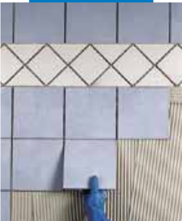
Τοποθέτηση μονόπυρου πλακιδίου σε τοίχο από γυψοσανίδα
