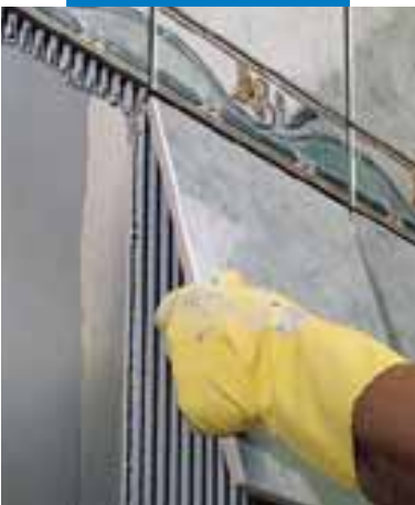
Τοποθέτηση μονόπυρου πλακιδίου σε επιχρισμένο τοίχο
