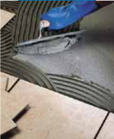
Τοποθέτηση μονόπυρου πλακιδίου σε δάπεδο
