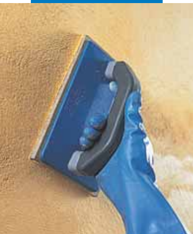
Εξομάλυνση του Silexcolor Tonachino με σπάτουλα με σφουγγάρι
