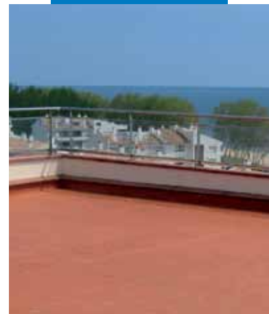
Επίπεδη οροφή στεγανωμένη με Aquaflex Roof
