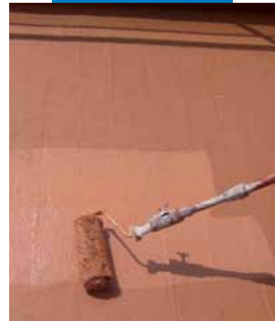
Εφαρμογή Aquaflex Roof με μακρύτριχο ρολό
