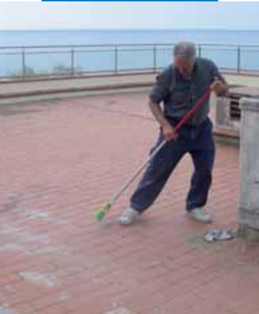
Καθαρισμός υποστρώματος πριν τη χρήση του Aquaflex Roof
