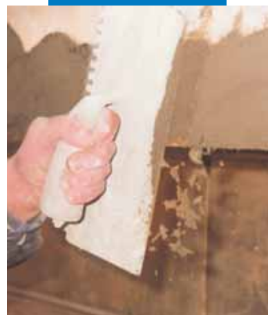
Αποκατάσταση της μπροστινής όψης της πλάκας σκυροδέματος ενός μπαλκονιού: τελείωμα
