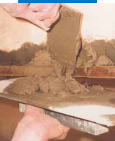
Αποκατάσταση της προστινής όψης της πλάκας σκυροδέματος ενός μπαλκονιού: εφαρμογή του Planitop 400
