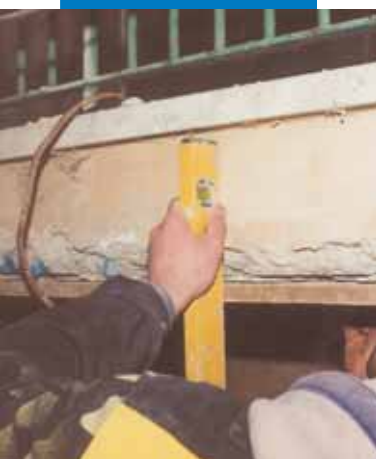
Αποκατάσταση της προστινής όψης της πλάκας σκυροδέματος ενός μπαλκονιού: τοποθέτηση ξύλινου καλουπιού
