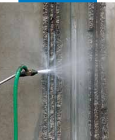
Καθαρισμός ράβδων οπλισμού
