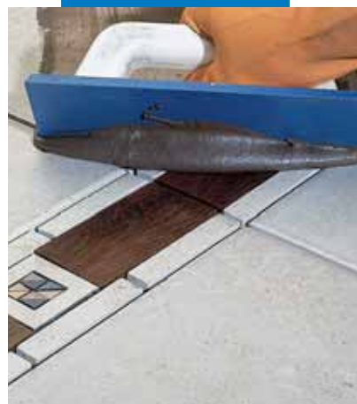
Αρμολόγηση δαπέδου με κεραμικά πλακίδια και εμφυτεύματα ξύλου με τη λαστιχένια σπάτουλα
