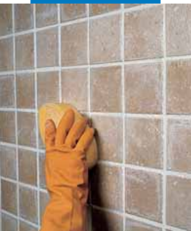
Φινιρίσμα σε τοίχο με μονόπυρο πλακίδιο με σφουγγάρι
