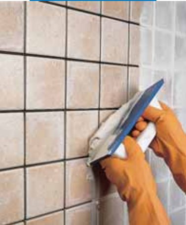
Αρμολόγηση σε τοίχο με μονόπυρο πλακίδιο με τη λαστιχένια σπάτουλα
