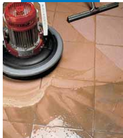
Φινίρισμα σε δάπεδο με πορσελανάτα πλακίδια με περιστροφικό τριβείο με δίσκο και λαστιχένια σκούπα
